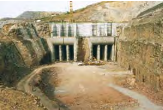
Foto 18 Estruturas de concreto dos túneis de emboque T1 e T2 - agosto de 1999.
