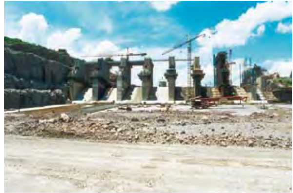
Foto 23 Estruturas de concreto do vertedouro – dezembro de 2000.
