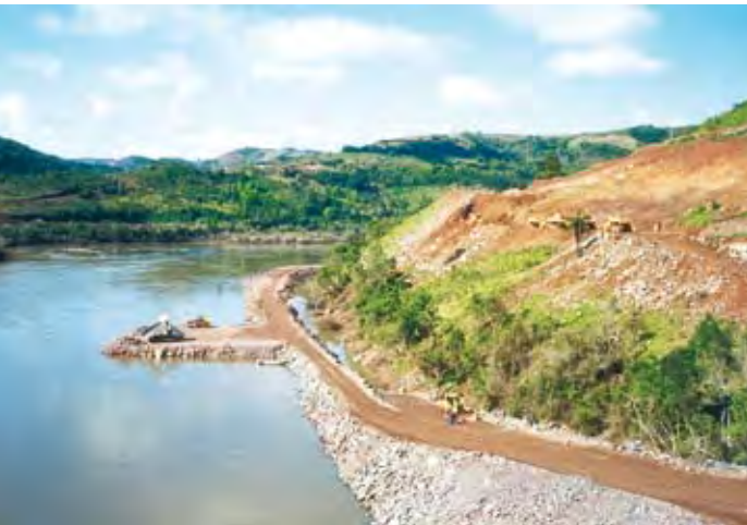
Foto 25 Lançamentos iniciais de materiais para a formação da base da barragem – setembro de 1998.
