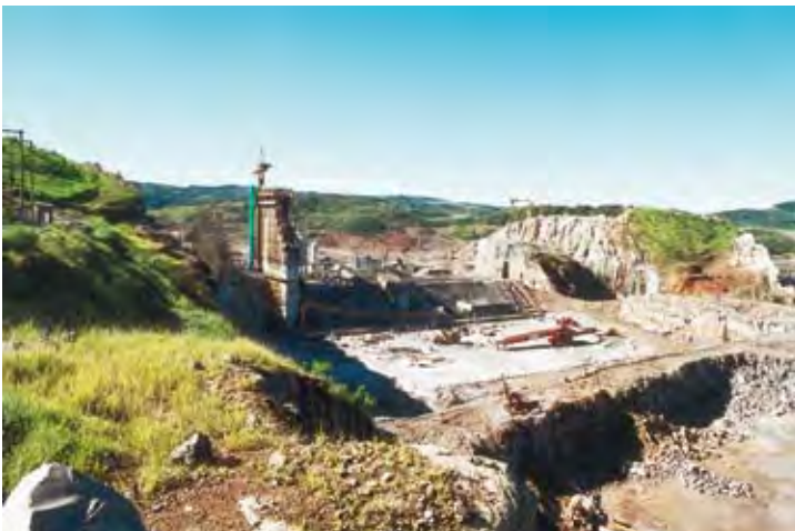
Foto 22 Vista de jusante do vertedouro – junho de 2000.
