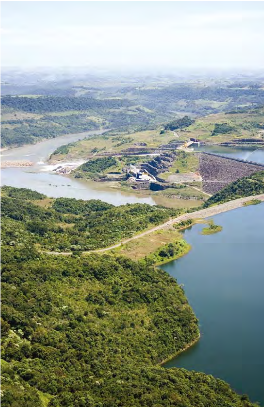
Foto 17 Recuperação de áreas degradadas da obra (canteiro).
