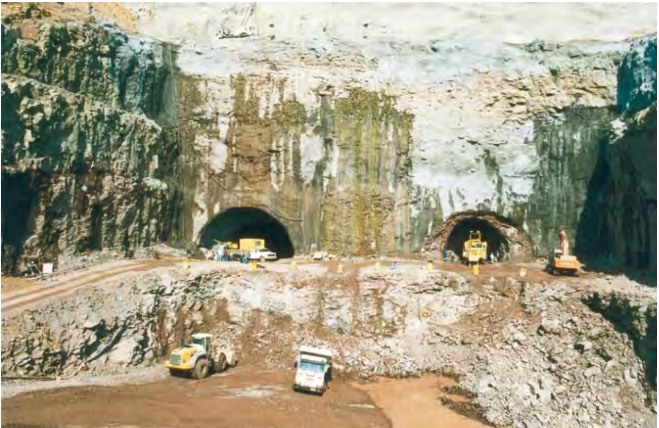
Foto 16 Escavações iniciais dos túneis de emboque T3 e T4 – setembro de 1999.
