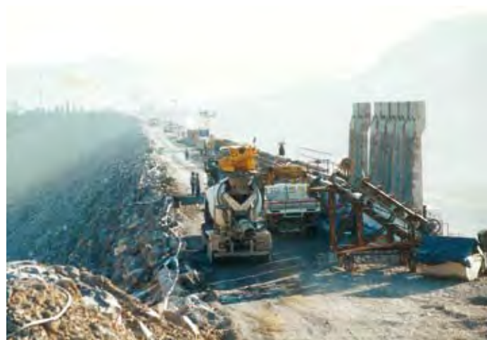
Foto 30 Topo da barragem, utilizado como via de acesso para os trabalhos de concretagem – abril de 2001.
