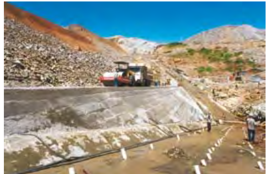
Foto 29 Base da barragem – janeiro de 2000.
