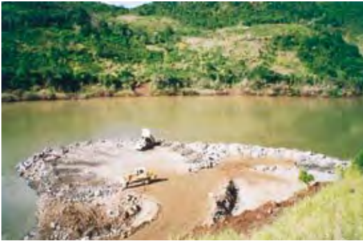
Foto 9 Início da construção da ensecadeira – junho de 1998.
