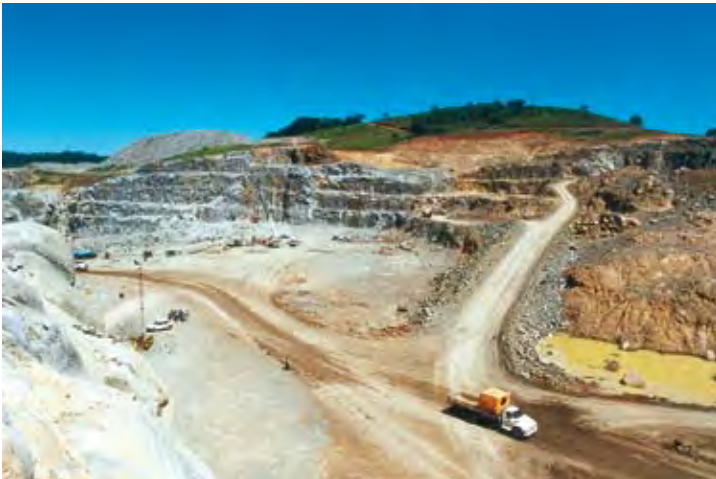
Foto 21 Escavações em rocha na área do vertedouro – janeiro de 2000.
