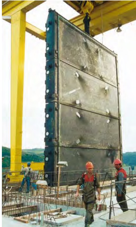
Foto 33 Comporta-vagão da tomada d'água.
