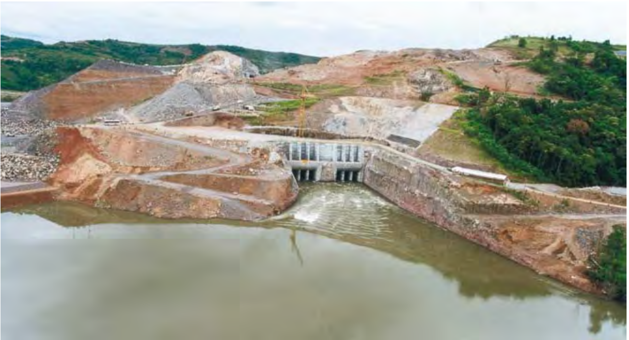
Foto 17 Desvio do rio pelos túneis inferiores T1 e T2 – outubro de 1999.
