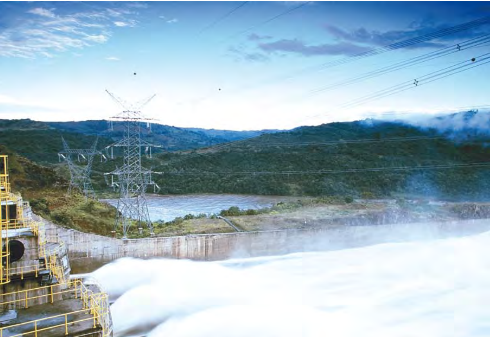
Foto 46 Linha de transmissão de 500kV que interliga a UHE Machado ao Subsistema Sul.
