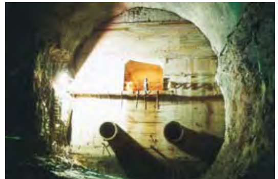
Foto 19 Estrutura para a selagem interna dos túneis.
