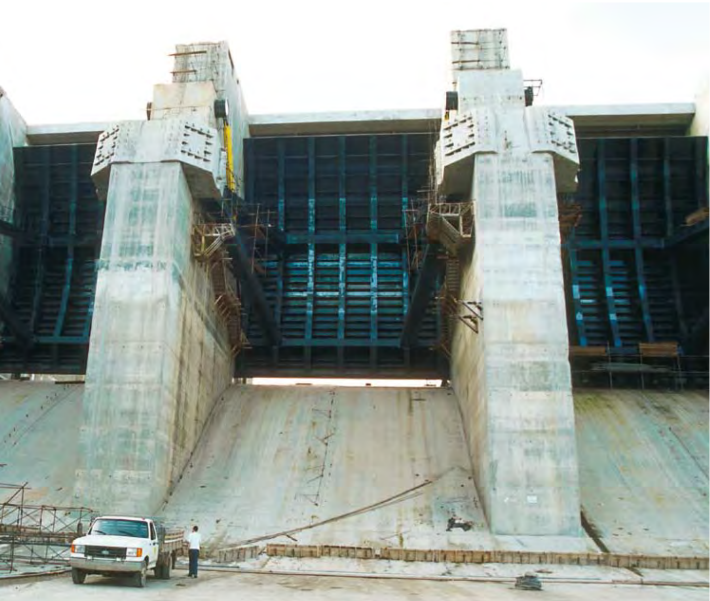
Foto 24 Comportas do vertedouro – 2001.
