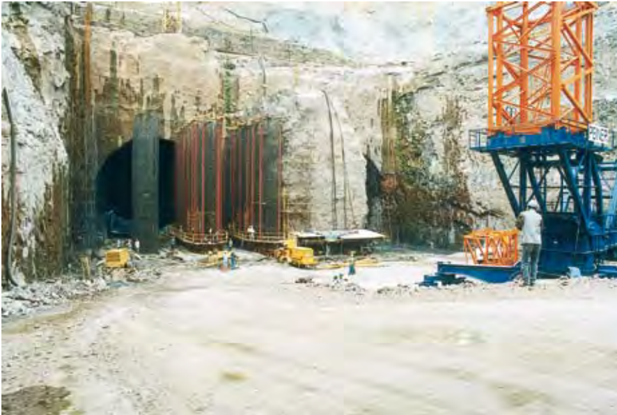
Foto 15 Armadura da estrutura do túnel de emboque T2 – dezembro de 1998.
