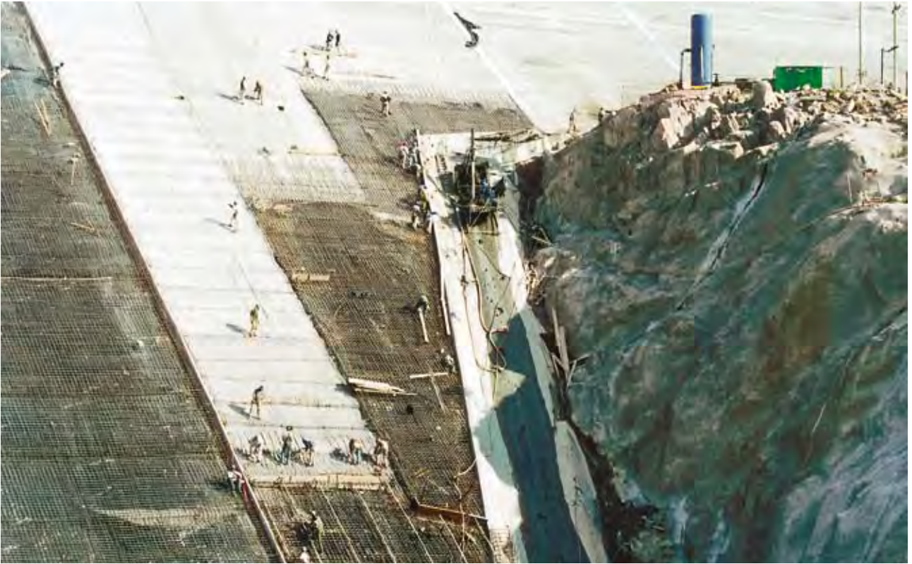
Foto 31 Concretagem da barragem – abril de 2001.
