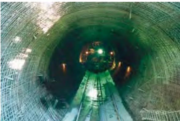
Foto 13 Armações de ferro no interior dos condutos forçados – março de 2001.
