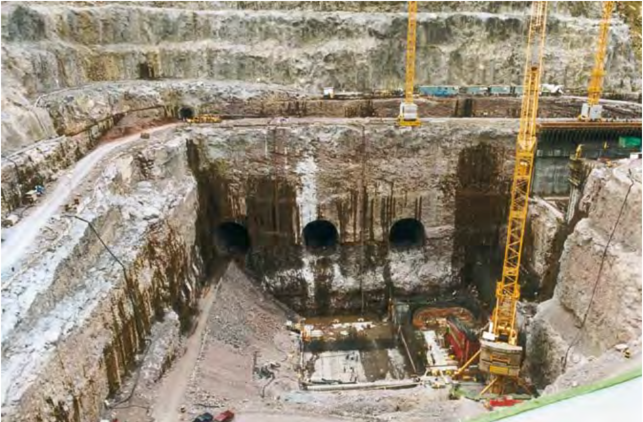
Foto 12 Saída dos condutos forçados na casa de força – outubro de 1999.
