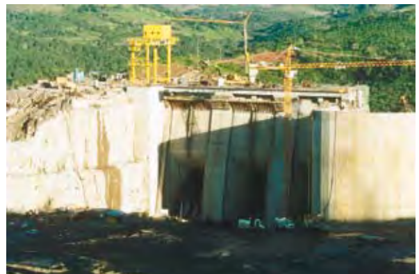
Foto 14 Estrutura de concreto da tomada d'água – maio de 2001.
