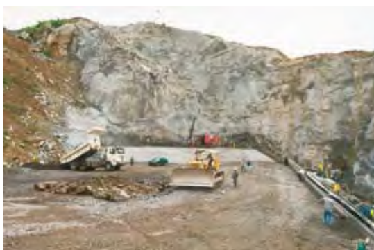
Foto 27 Concretagem do muro do plinto - abril de 2000.
