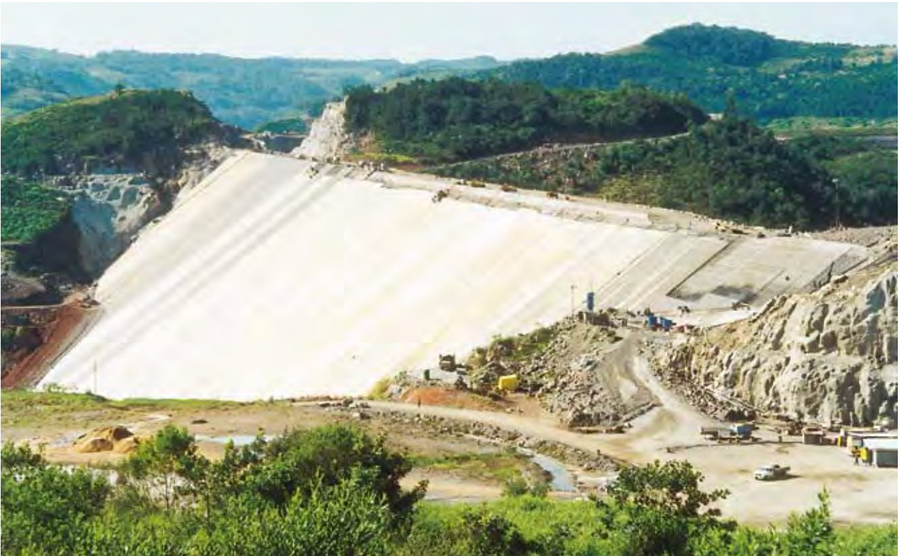
Foto 32 Fase final de concretagem.
