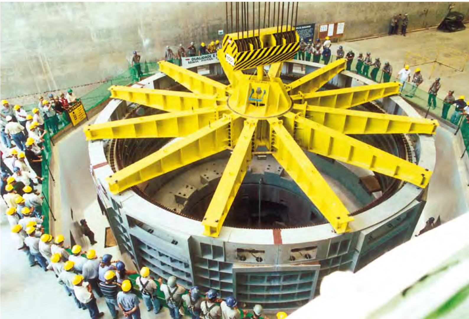
Fotos 36, 37 e 38 Operação de descida do estator nº 1 – junho de 2001
