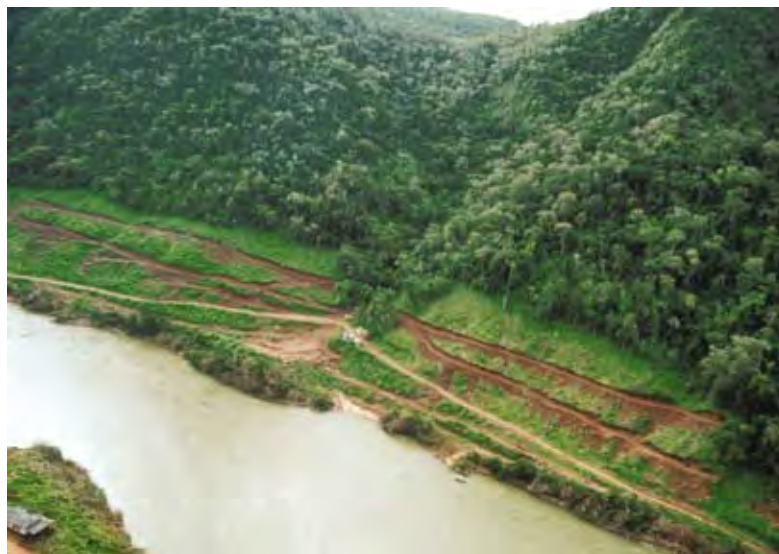
Foto 18, 19, 20 e 21 Atividades de limpeza da bacia de acumulação.
