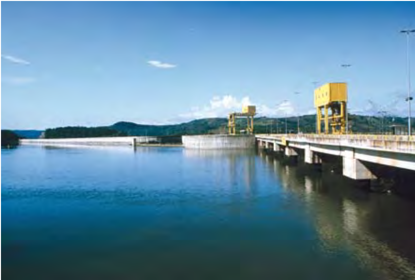
Foto 39 Reservatório, tomada d'água e vertedouro.
