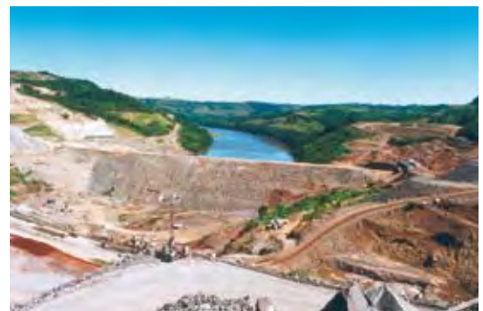
Foto 11 Conclusão da ensecadeira – janeiro de 2000.
