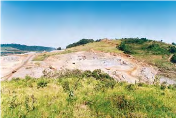
Foto 20 Escavações iniciais na área do vertedouro – novembro de 1998.
